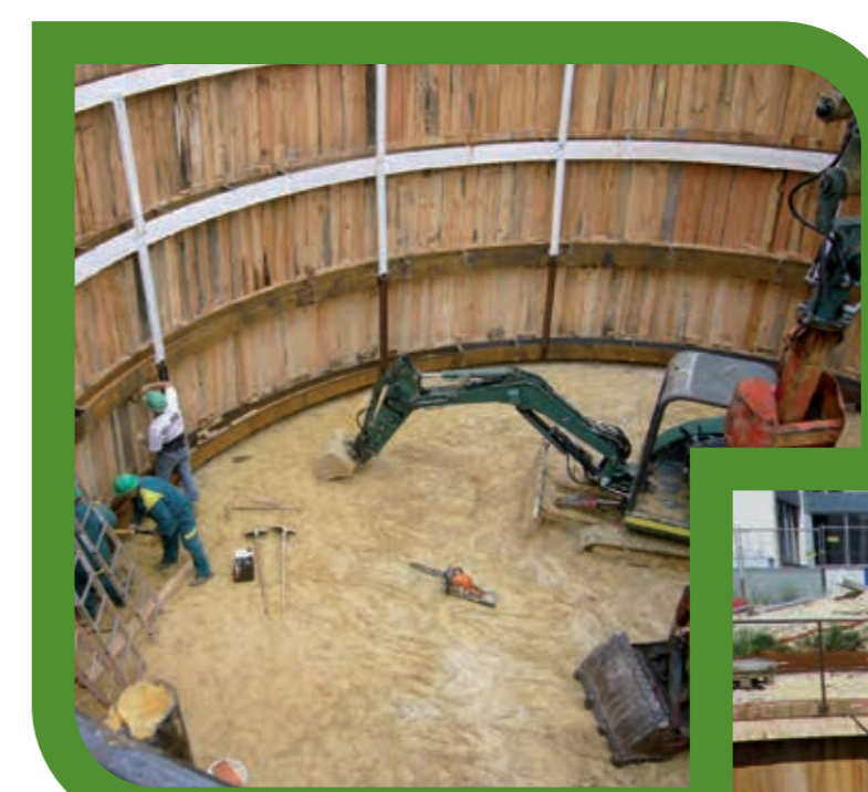
Opérations de préparation de la fosse.
