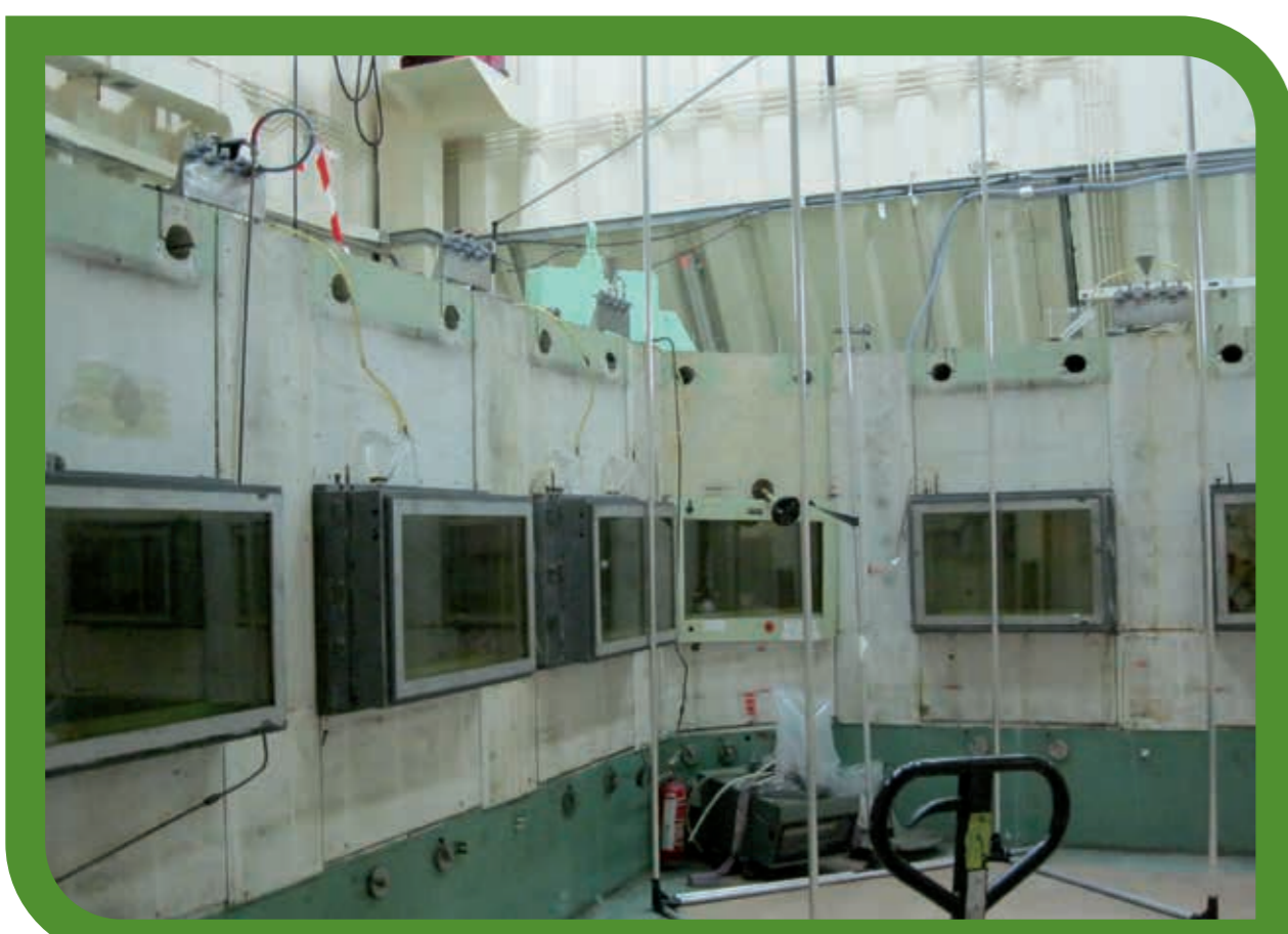
La chaîne Cyrano du bâtiment 18 après assainissement.
