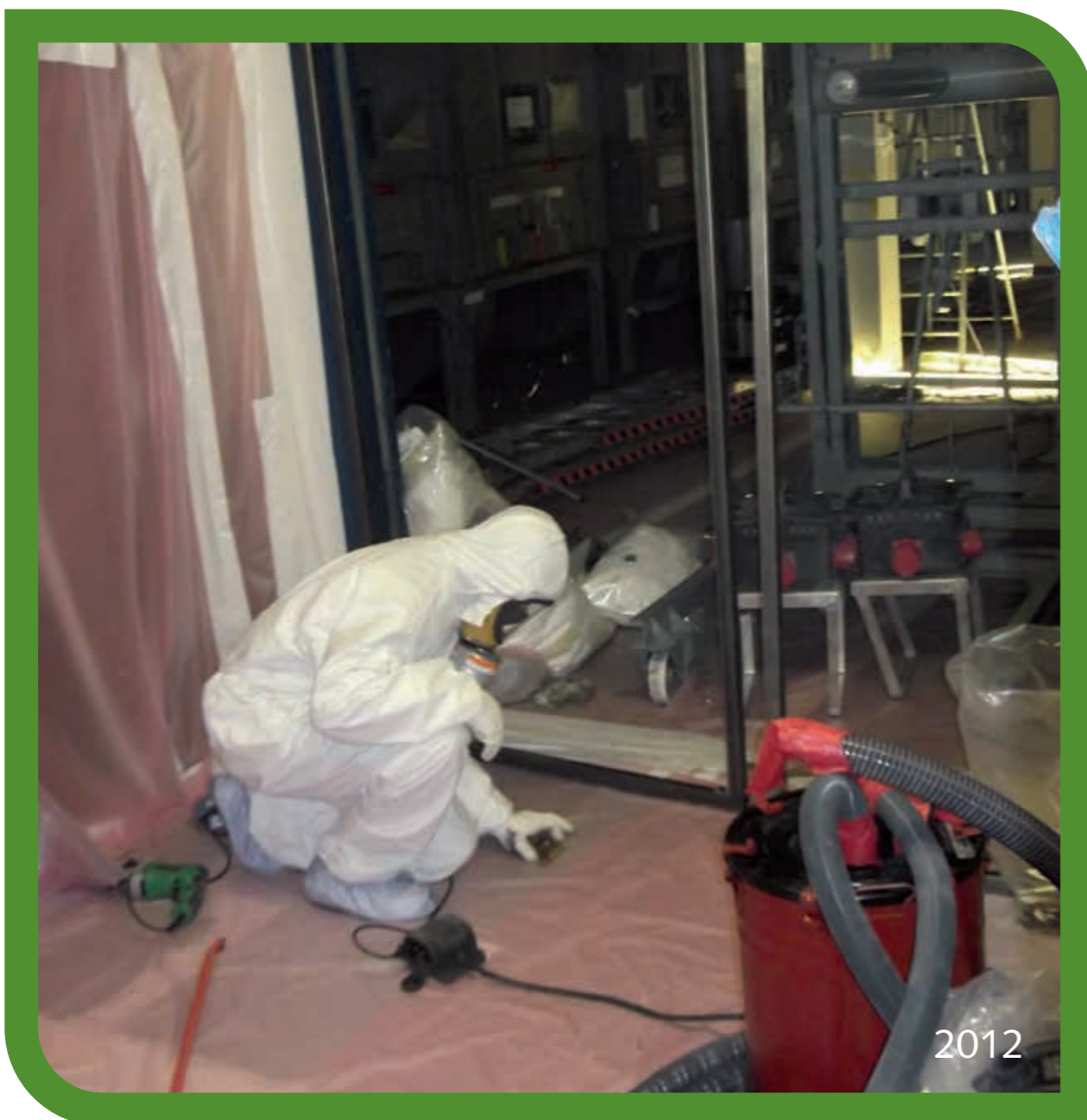
Démantèlement de la salle des filtres du laboratoire de radiométrie n°2 (RM2). Montage d'un sas de confinement avant l'intervention.
