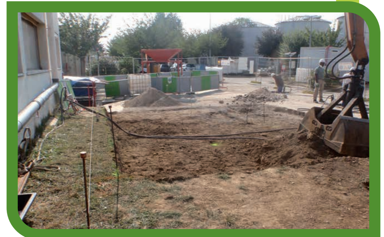
Remblaiement des 2 derniers mètres en grave naturelle compactée par couche de 30 cm.
