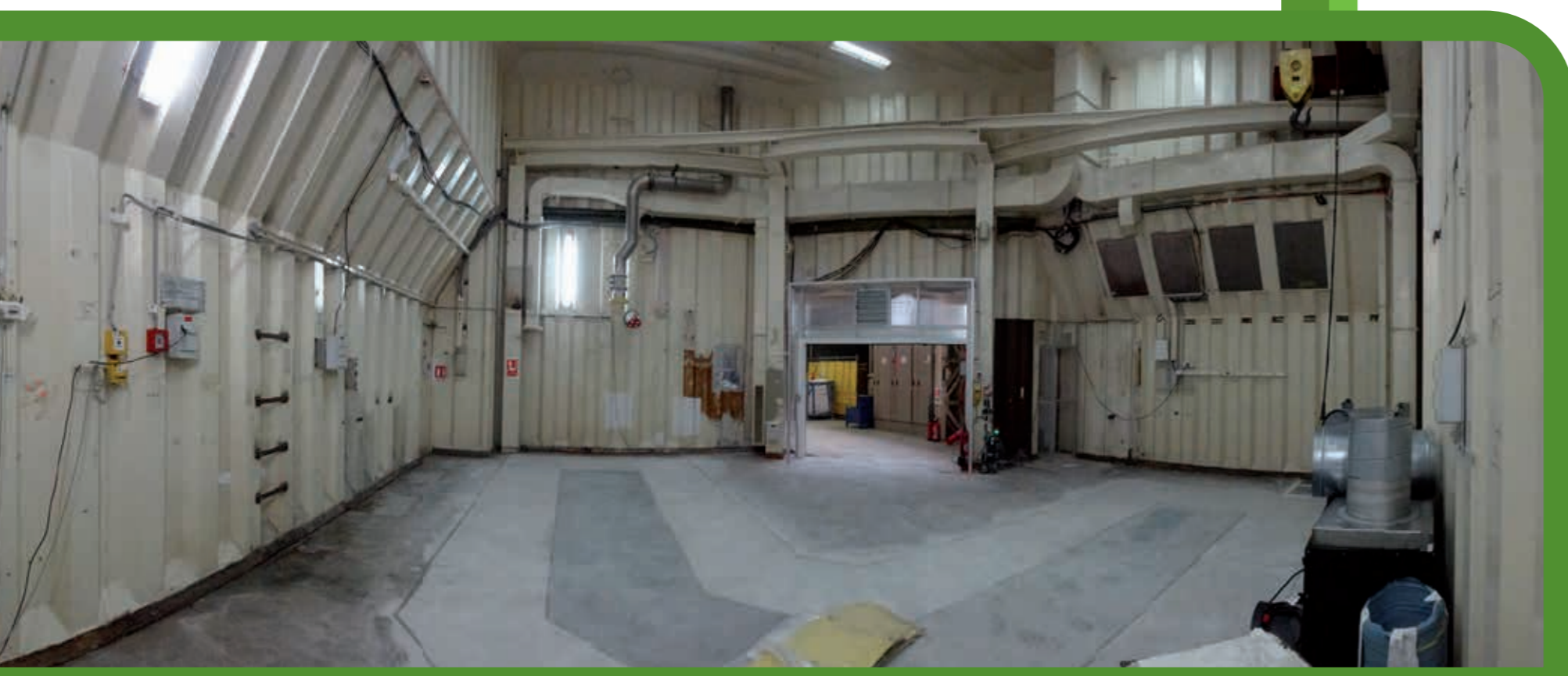
L'emplacement de la chaîne Cyrano bâtiment 18 après démantèlement.
