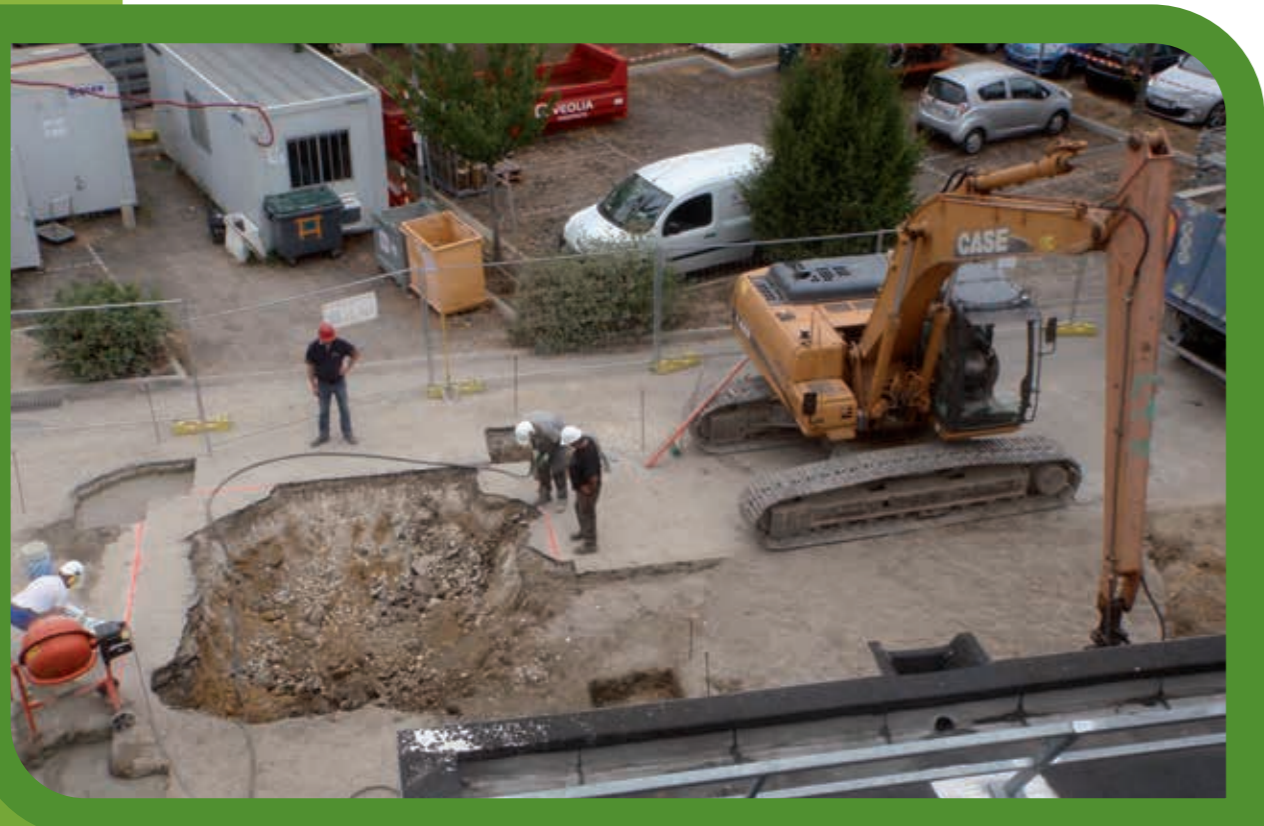
Préparation de la zone : retrait des bitumes et nivellement.
