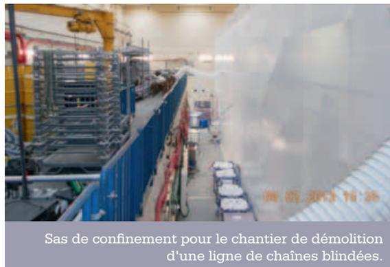
Sas de confinement pour le chantier de démolition d'une ligne de chaînes blindées.
