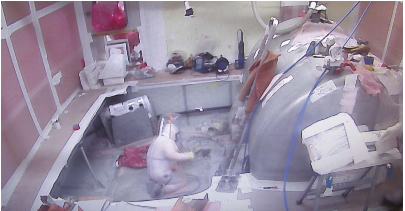
Découpe de cuves INB 166 bâtiment 50.
