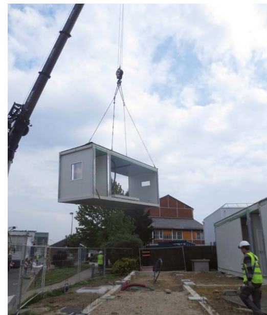
Mise en place des vestiaires modulaires de l'îlot INB 166.
