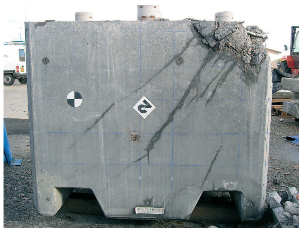
Fig. 73. Conteneur B2.1 après essai de chute et extraction de son couvercle.
