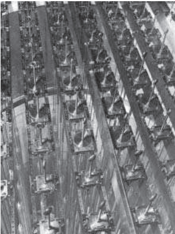
Fig. 24. AQUILON, maquette critique destinée à la qualification des réacteurs à propulsion nucléaire.
