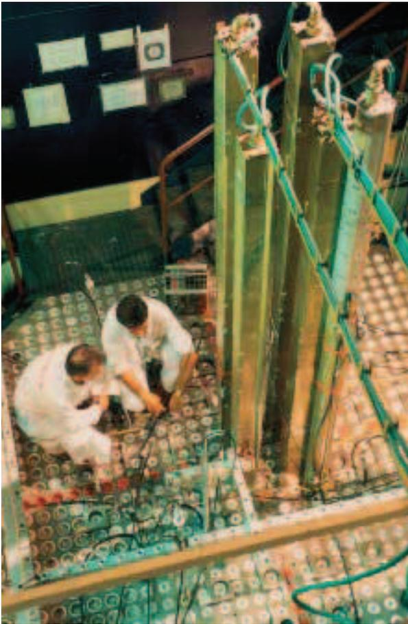
Fig. 53. Vue de la taque de suspension du cœur et des mécanismes des barres de sûreté de MASURCA.
