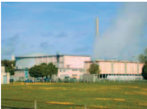
Fig. 61. Vue d'ensemble du réacteur OSIRIS.
