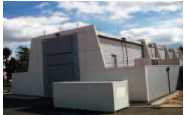
Fig. 78. Le laboratoire chaud LECI, à Saclay, pour l'étude des matériaux irradiés.
