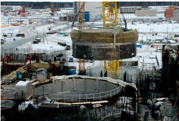
Fig. 194. Réacteur BN 800 : mise en place de la cuve principale (2011).
