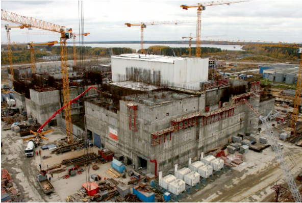
Fig. 193. Chantier de construction du réacteur BN 800, bâtiment réacteur (2011).
