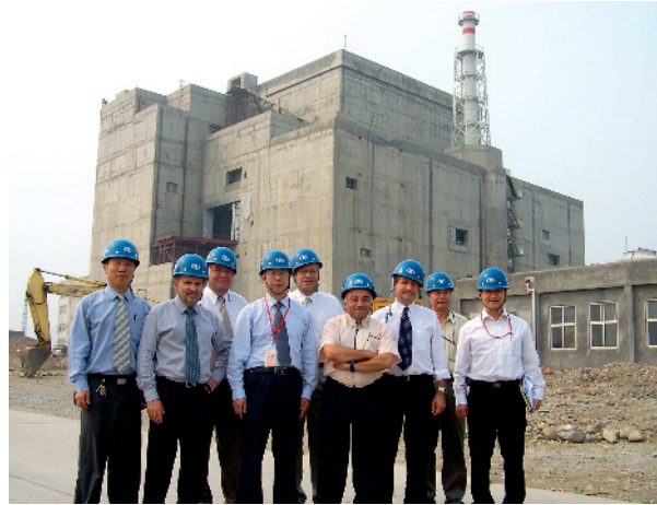
Fig. 199. Le réacteur CEFR en construction (2007), lors de la visite d'une délégation française.
